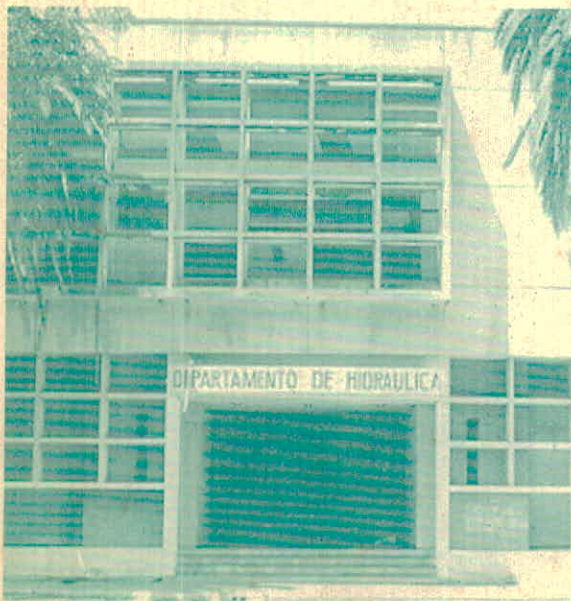
Departamento de Hidráulica
